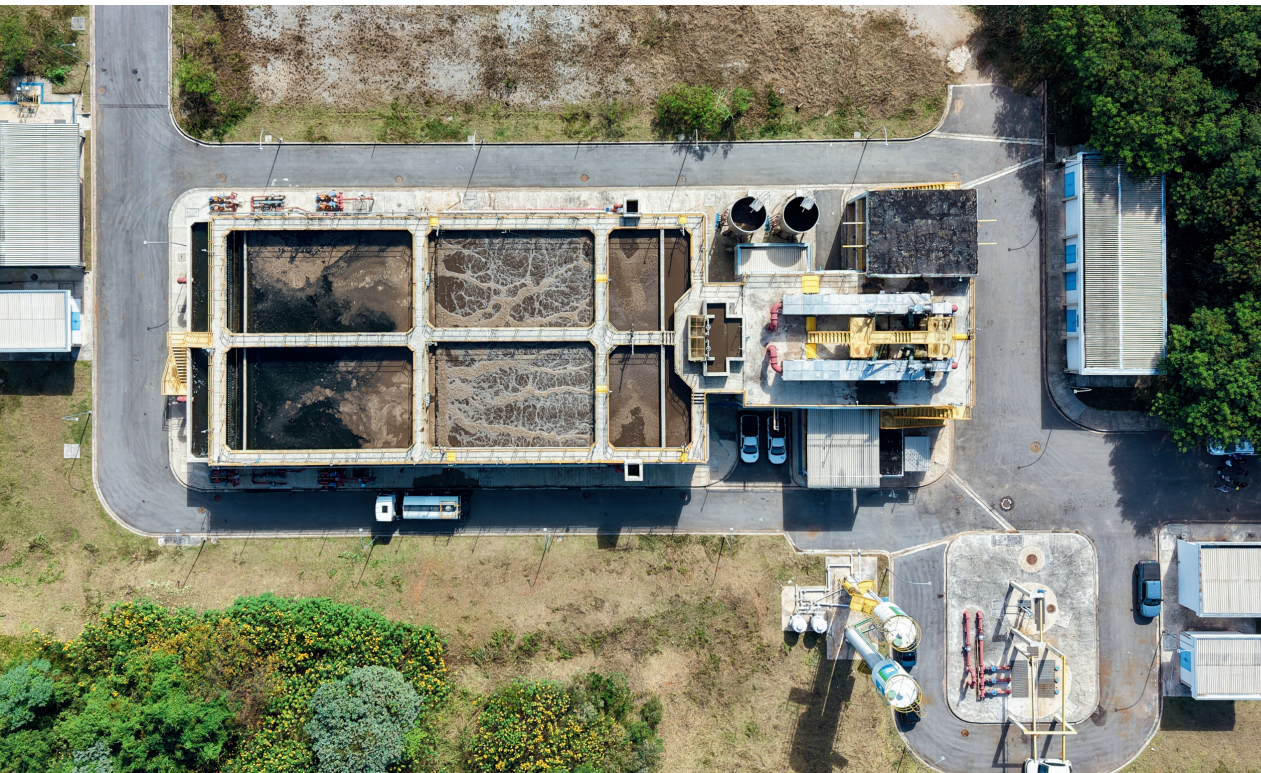
A ETE do Polvilho já está em operação atendendo diversos bairros de Cajamar e possui projeto de ampliação para dobrar sua capacidade de tratamento de esgoto
