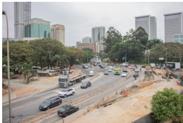
A ViaOeste inicia nova etapa das obras de duplicação das marginais da Castello Branco
