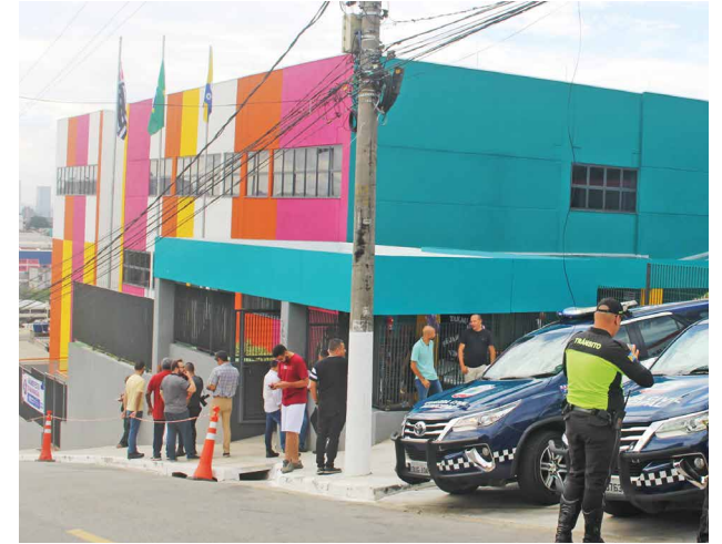
A Escola Infantil possui 4.011,63 m 2 de área construída, quatro pavimentos, 12 salas de aula
